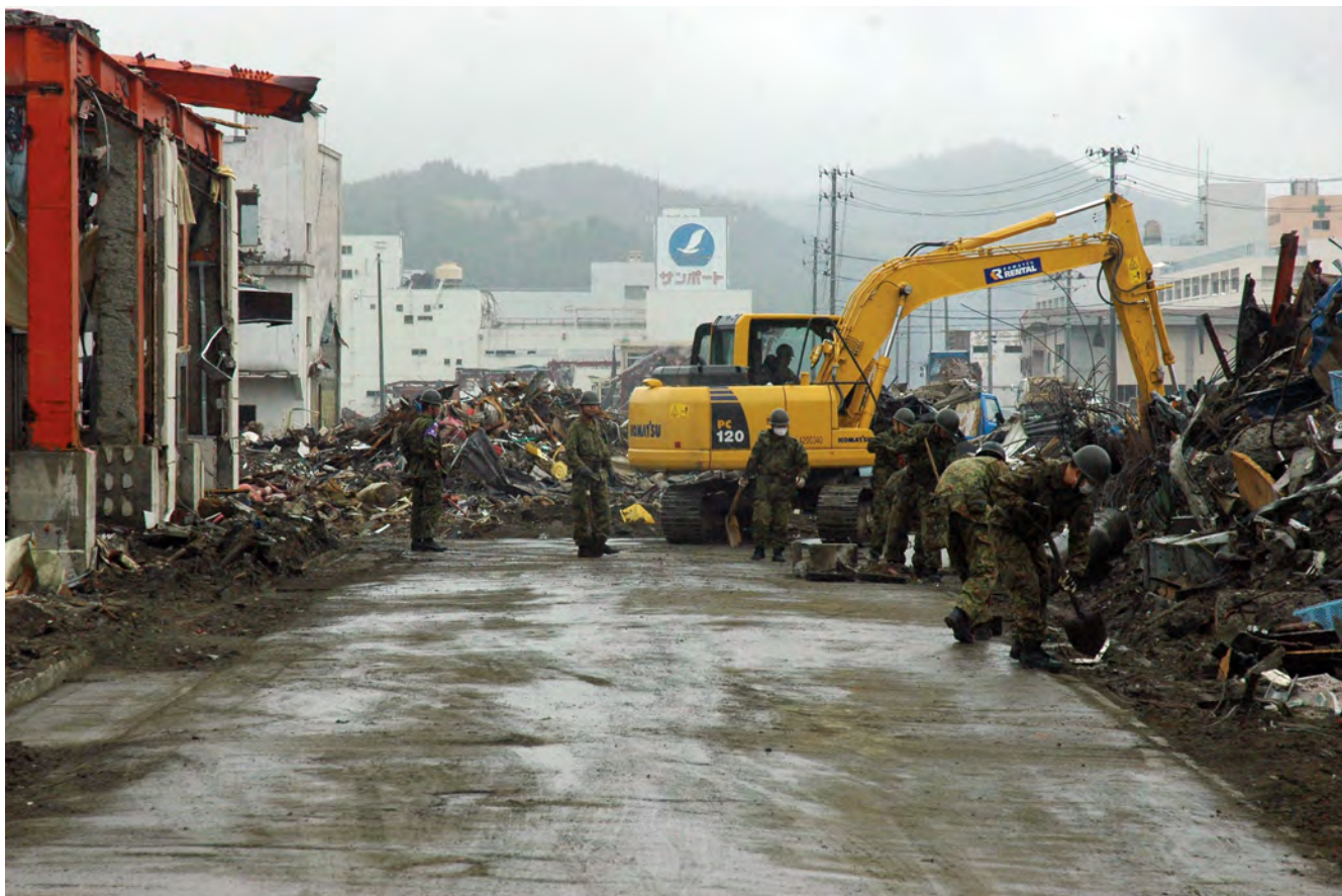
▲志津川地区での道路の瓦礫を取り除く陸上自衛隊北部方面隊（2011（平成23）年5月12日）
