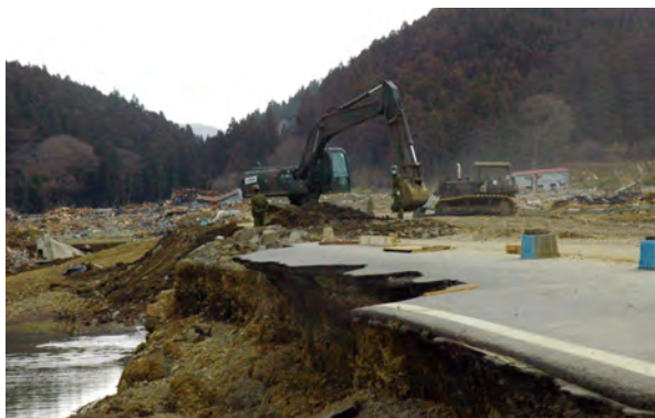
▲戸倉地区の国道45号を補修（2011（平成23）年3月22日）
