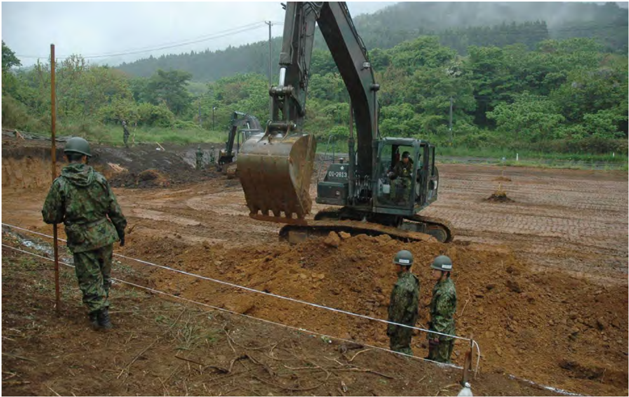
▲南三陸町は平地が少ないため、仮設住宅建設のためには新たな用地造成作業が必要だった。 陸上自衛隊北部方面隊が用地造成作業に当たった。
