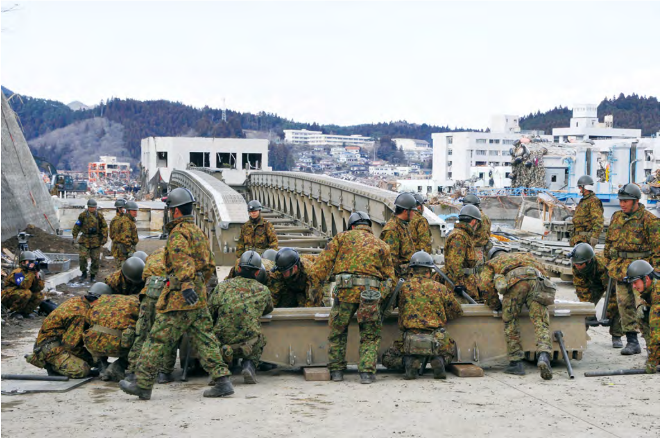
▲巨大な構造材の組み立てを行う陸上自衛隊東北方面隊第2施設団。
