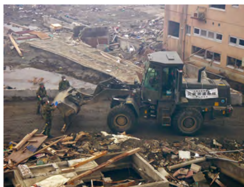
▲志津川地区での道路復旧（2011（平成23）年5月1日）
