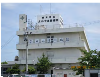
▲2011（平成23）年6月1日 登米市立よねやま診療所の一部に入院病床39床の公立志津川病院開設。
