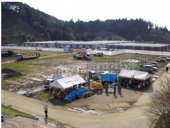
▲ 志津川國中操場上的臨時住宅建設
