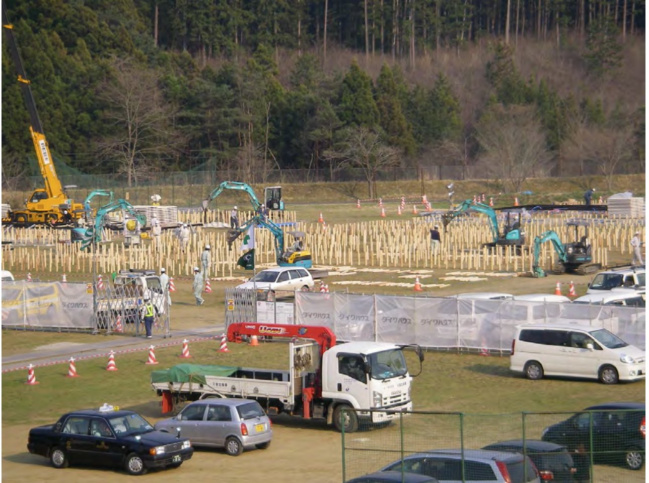
▲ 志津川國中操場上開始建造臨時住宅
