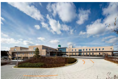
▲南三陸病院・総合ケアセンター南三陸全景
