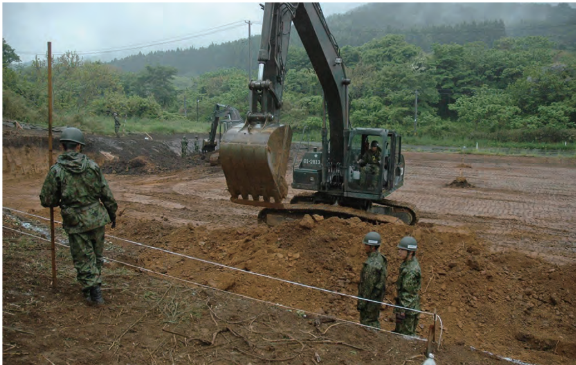
▲由於南三陸町缺乏平地，為了建設臨時住宅就必需建造新的用地。陸上自衛隊北部方面隊承擔了用地建造工程。
