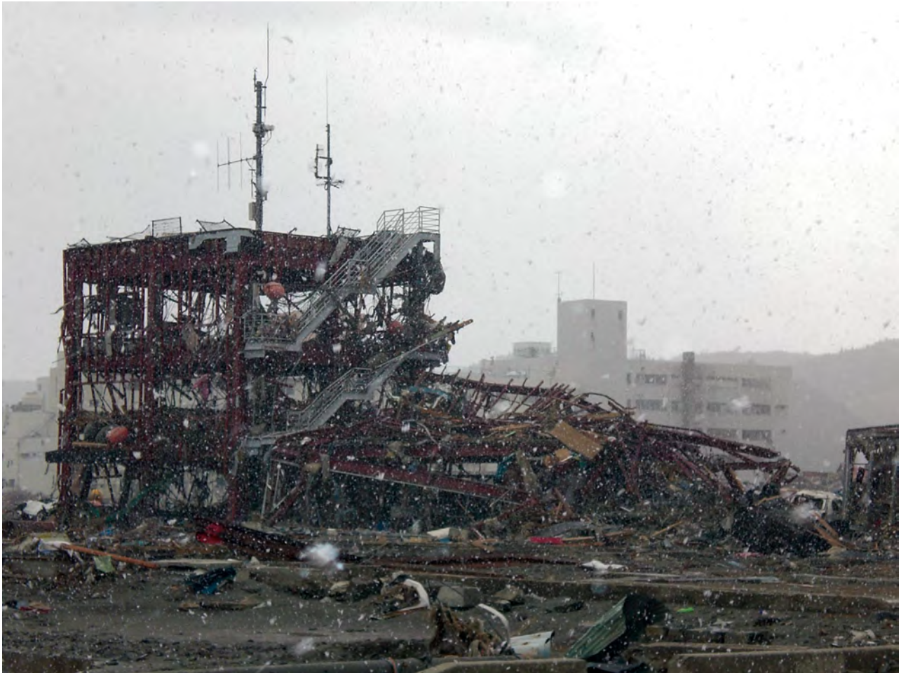
▲倒塌在防災對策廳舍右側的殘骸為第 2 政府機關建築。海嘯的最大浪是由逃生口樓梯的反方向湧進。廳舍的背後鱗次櫛比的住宅以及店舖已被破壞不留痕跡。
