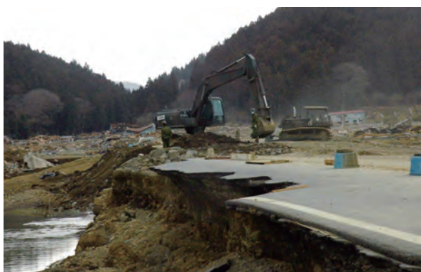
▲修補戶倉地區的45號國道(2011年3月22日)
