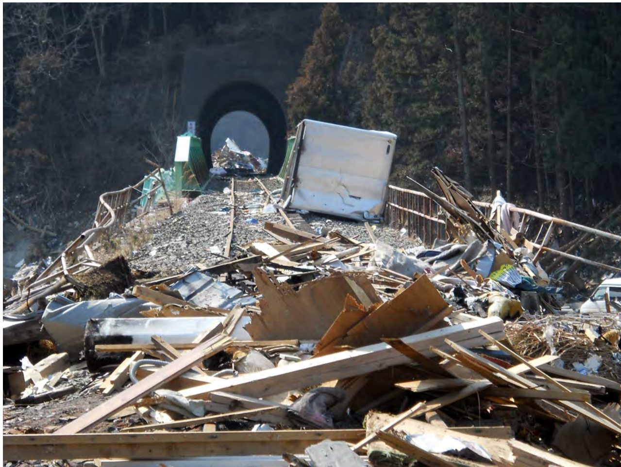
▲ 鐵路的高架橋也被瓦礫覆蓋。
