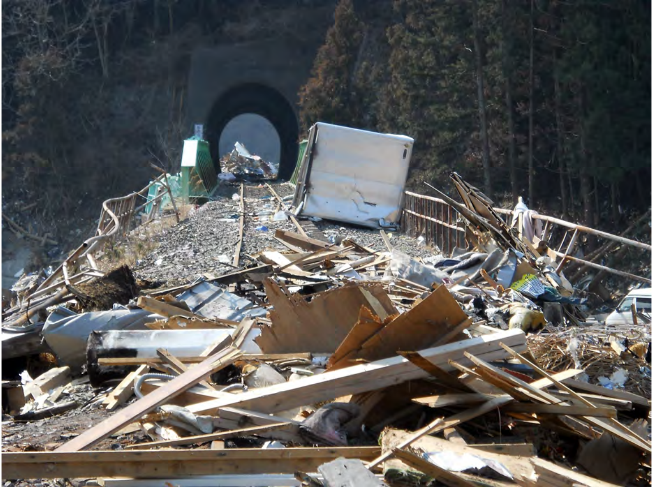
▲鉄道の高架も瓦礫で埋め尽くされていた。
