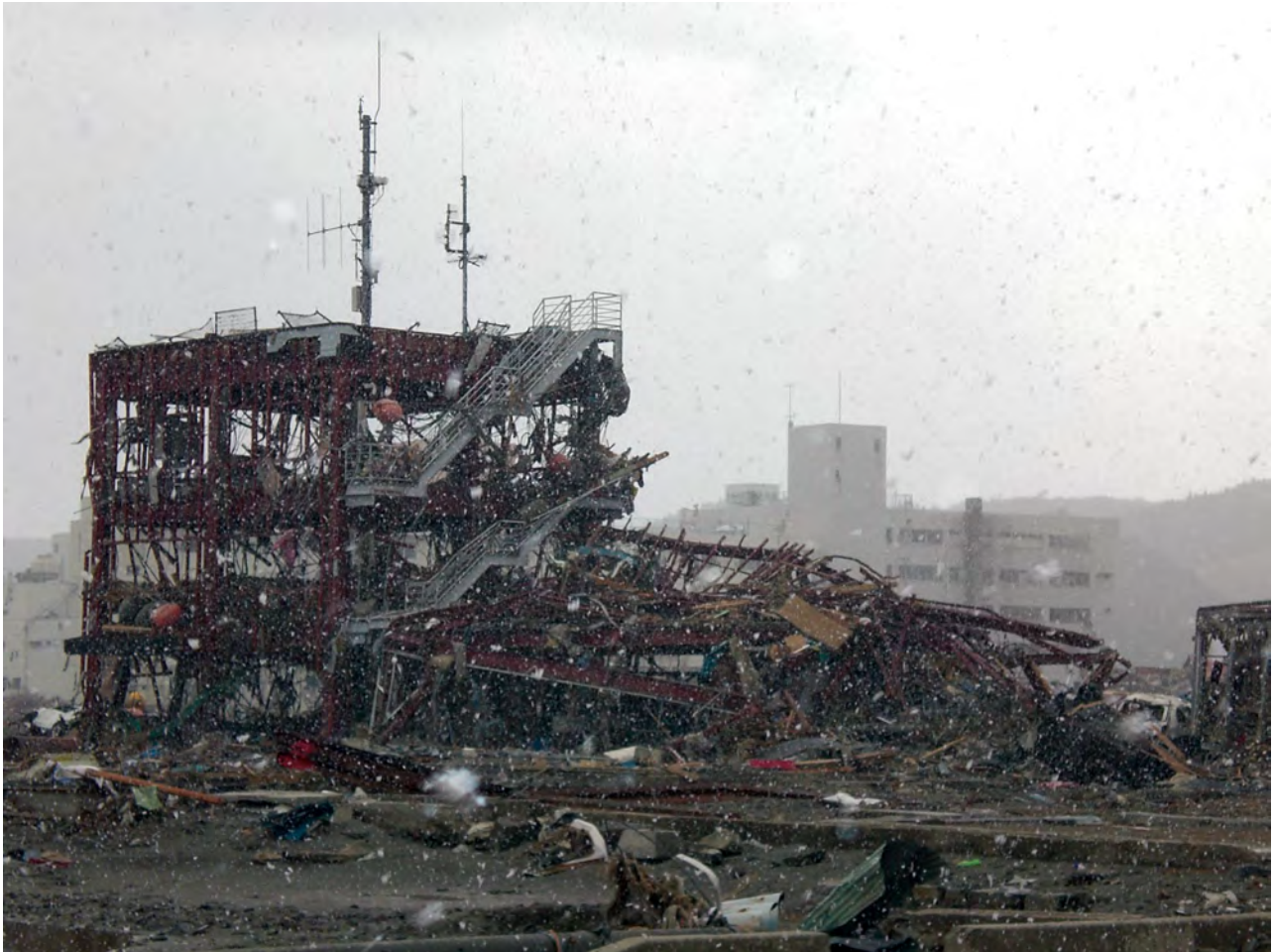
▲防災対策庁舎の右側にもたれかかる残骸は役場第2庁舎。津波の最大波は非常階段の反対側から襲った。庁舎の背後にぎっしりと建ち並んでいた住宅や店舗は跡形もなく壊滅した。
