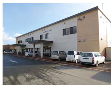
▲2012（平成 24）年 4 月 1 日 沼田に仮設建物が完成。日本赤十字社の支援を受け、仮設公立南三陸診療所が開設された。
