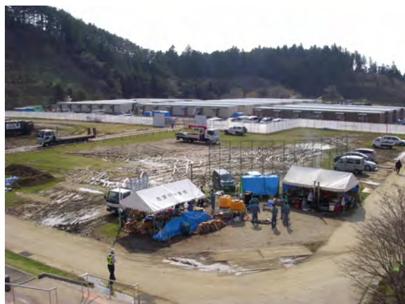
▲志津川中学校校庭の仮設住宅建設 2011（平成）23 年 4 月 26 日
