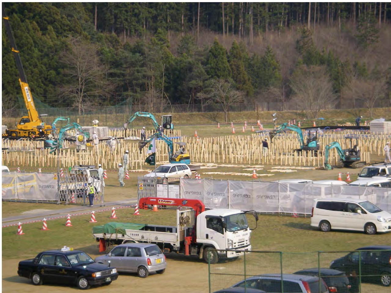
▲志津川中学校の校庭で始められた仮設住宅建設（2011（平成 23）年 4 月 14 日）
