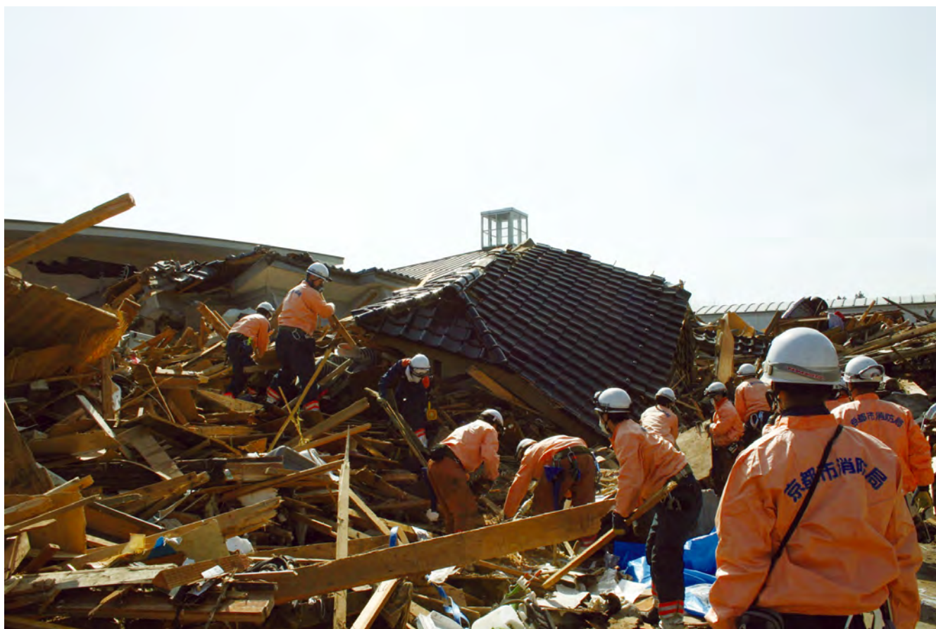
▲大津波から一夜が明けた志津川地区で生存者を搜索する京都市消防局の緊急消防援助隊
