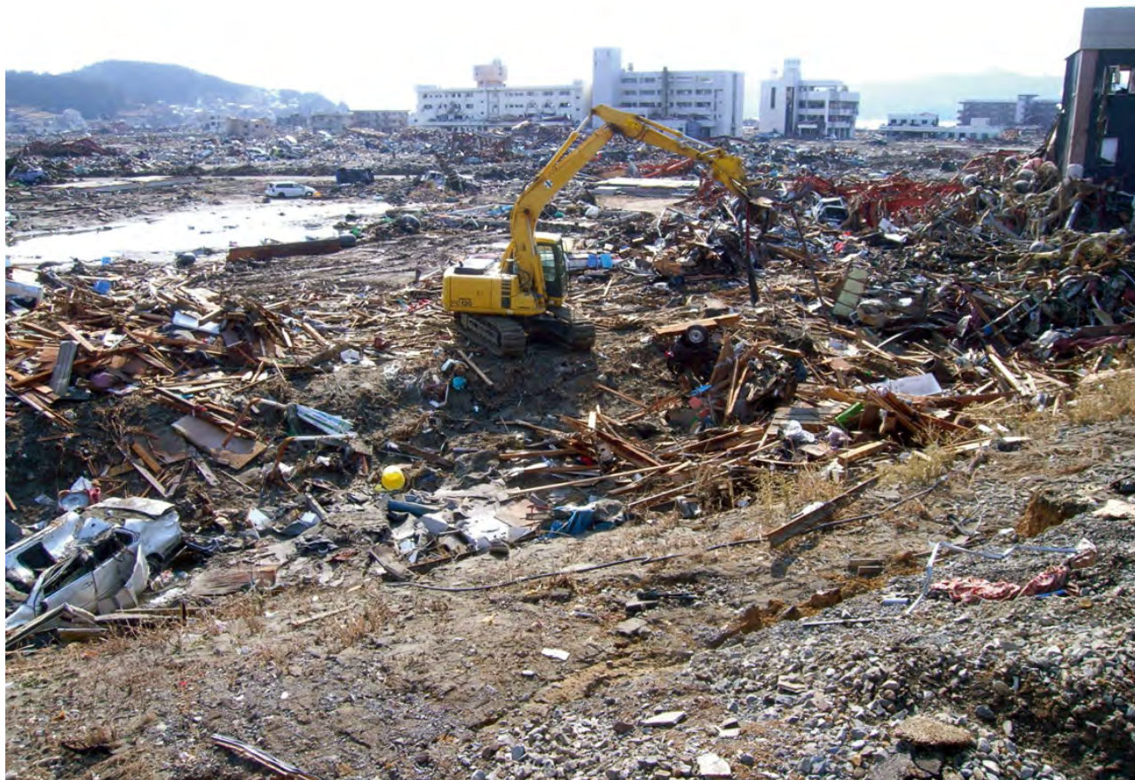
▲震災翌日から地元の建設会社の重機が瓦礫の町で稼働し続けた。
